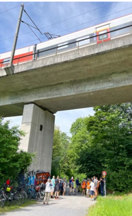
Stopp mit Geschichte(n) beim Jöchler-Viadukt in Baar.
